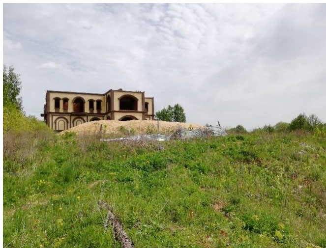
Рис. 1 – Маршрутное обследование нарушений в водоохранной зоне р. Малая Кокшага
