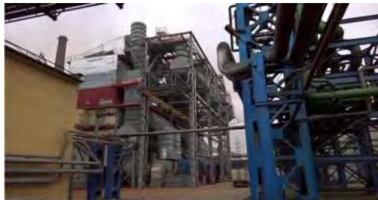
Рисунок 6.25 – Водооборотная система в ЭСПЦ с двумя печами ДСП-180
